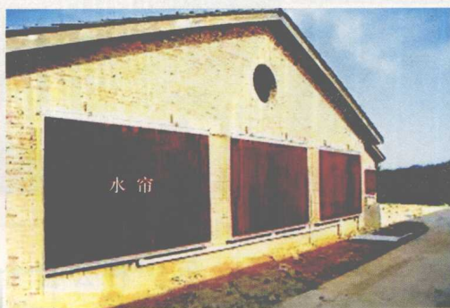
图1-8 纵向通风东墙(水帘)
