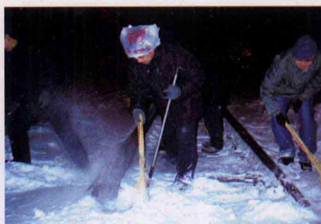
铁路职工连夜清理路轨上的积雪,始终保证道岔运行良好。
