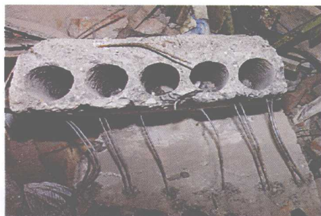
彩图 15 钢筋混凝土
