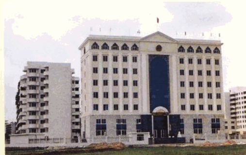
分局机关办公大楼
