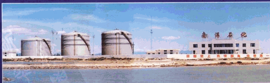
仓储能力达 18000 立方米的南洋船务东方油库
