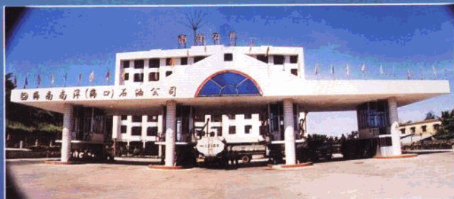
能储存 16000 立方米的南洋船务海口油库
