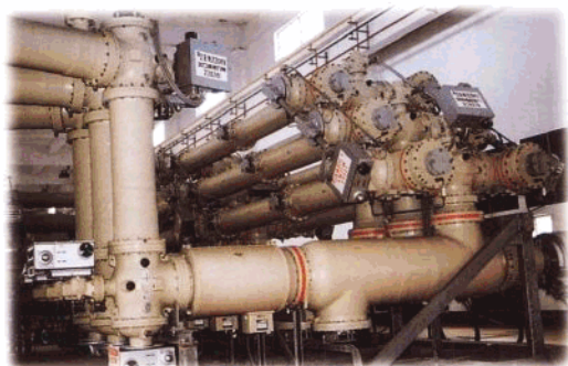
海南省 220 千伏永庄变电站引进的目前世界上一流的瑞士 ABB 公司 GIS 组合电器
