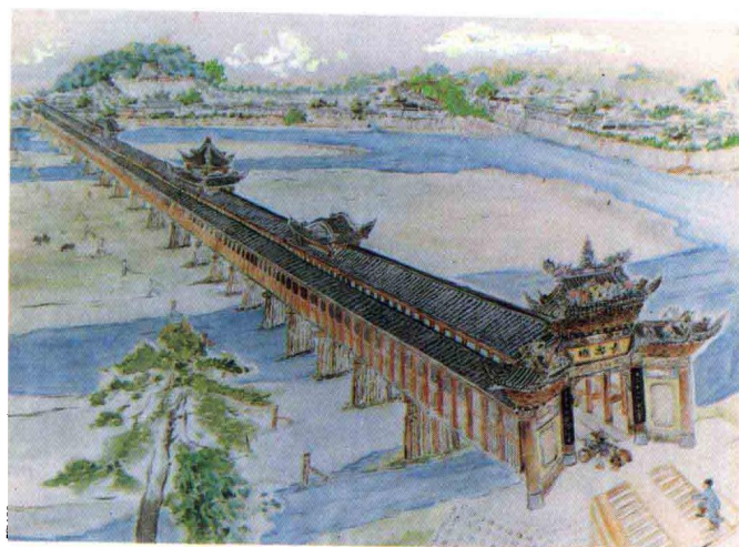
◀ 1930年所建的桥楼木梁桥——元通长寿桥，桥长79.2丈，桥楼99间，寓九九长寿之意
