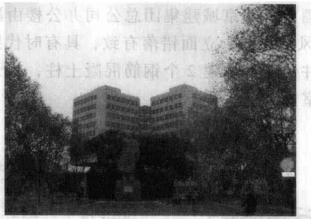
图 1.9 同济大学图书馆内筒式悬挑加层
