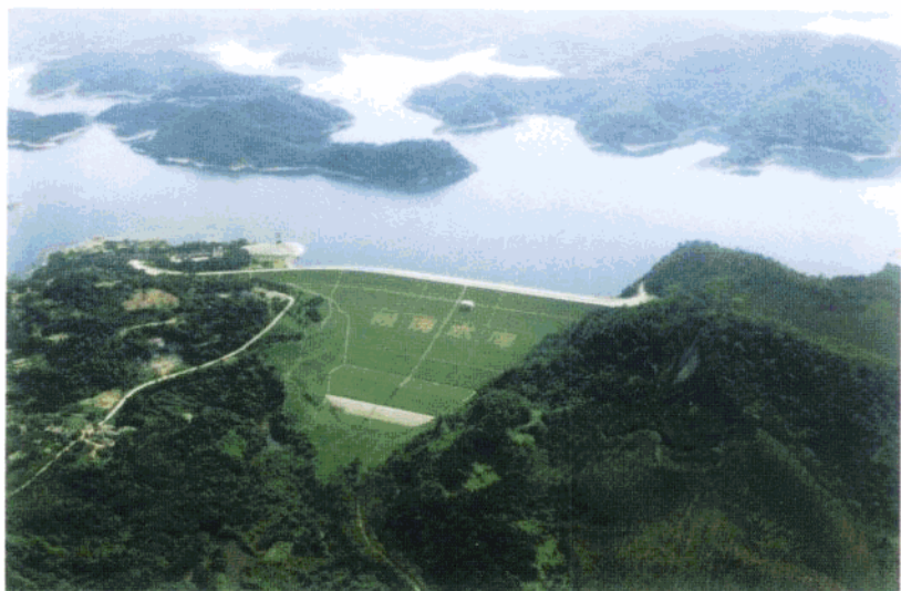
▲松涛水库大坝
