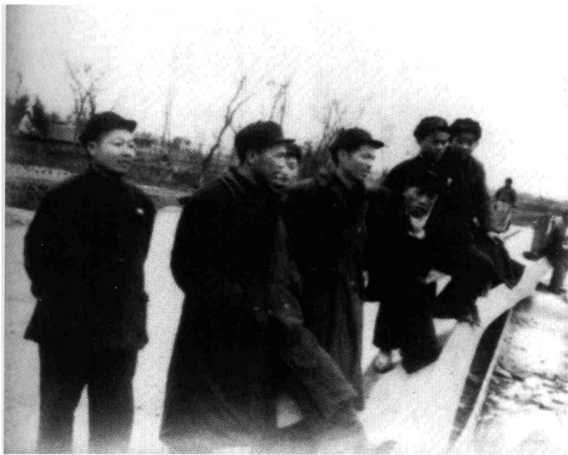
县长浦太福等同志在检查江堤的抢修情况
