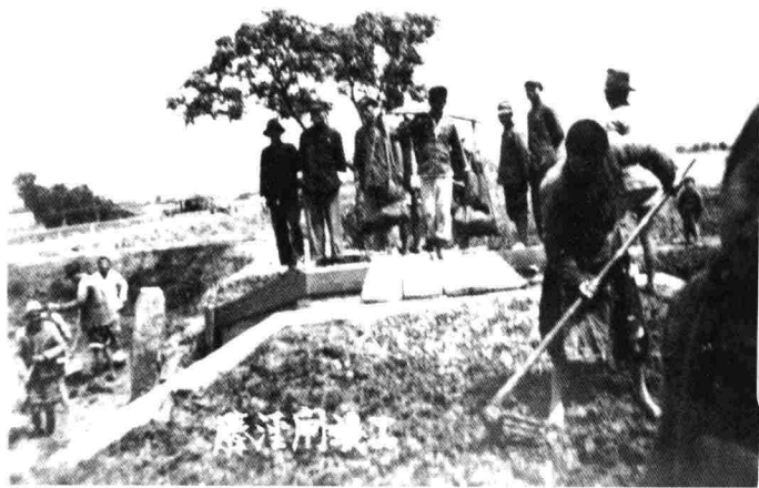
牌楼糜泾闸建设竣工的情况
