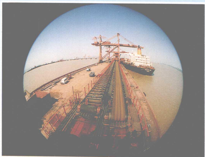
宁波港系国家重点开发的我国大陆四大国际深水中转港口之一。这是北仑港于1995年建成投产的20万吨级、能兼靠30万吨船舶的卸矿泊位,它正在接卸30万吨特大型矿船“大凤凰” 吴元柳摄
