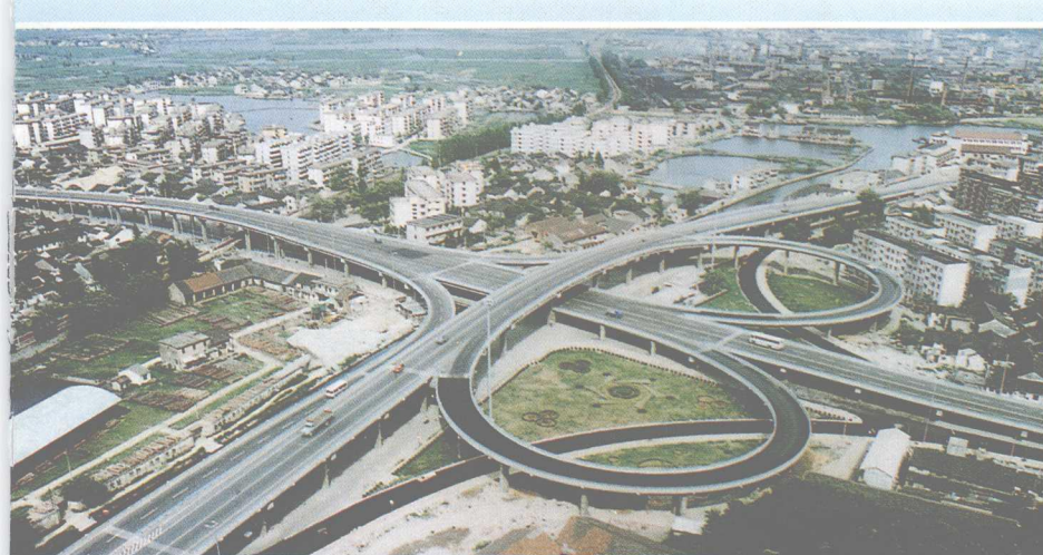
我省目前最大的城市半互通式立交桥——绍兴昌安立交桥于1995年12月26日通车
