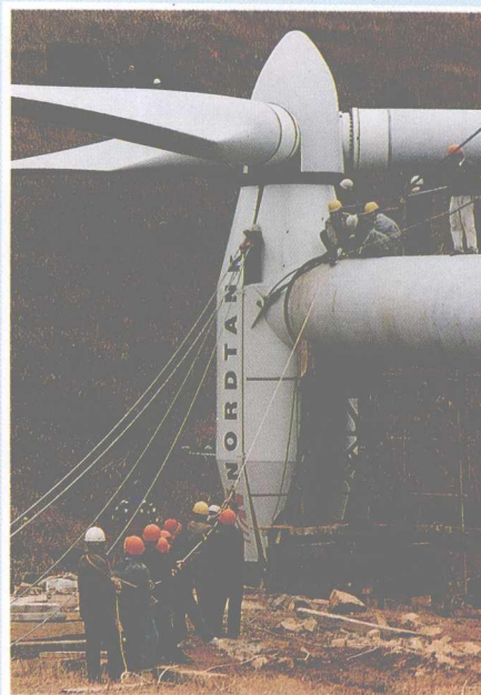
我省风力发电已转入大规模商业开发运营阶段。1995年12月下旬,我国目前单机容量最大的两台500千瓦风力发电机组正在温州市苍南县鹤顶山主峰整体吊装 周星健摄
