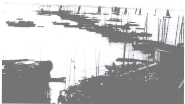
海堤运石船 队一字摆开，投 石断流。
