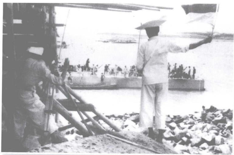
沉箱被拖至堤线待沉放。“请看令旗，听我指挥！”
