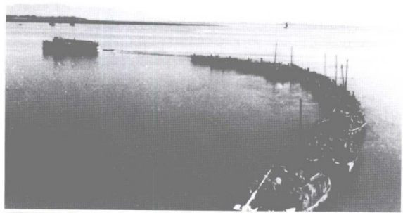
海上一列式拖带 法，海堤运石船队刷 新全国拖运记录。
