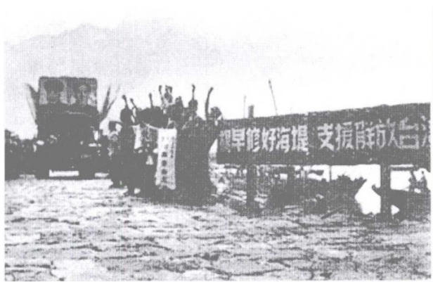
1954年10月15日，海堤完成第一期工程，低潮时汽车可全线通行。图为通车典礼。
