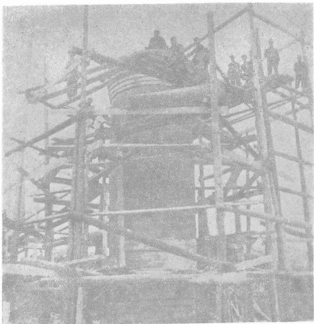
榕江龙头鉄厂洋高炉正在紧张修建中
