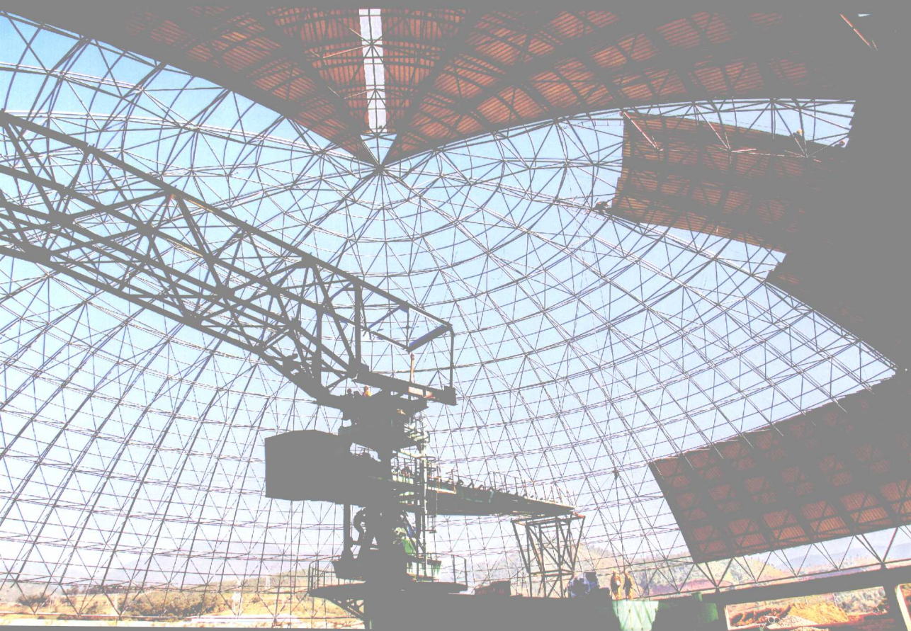
正在建设中的西昌航天 200万吨干法旋窑水泥厂 原料均化储存车间。
