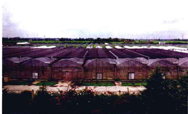
闵行区马桥园艺场 国产智能连栋温室
