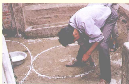
建沼气池第一工序的定点放线
