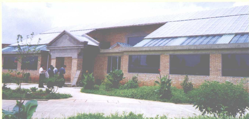
云南太阳能利用与建筑一体化示范
