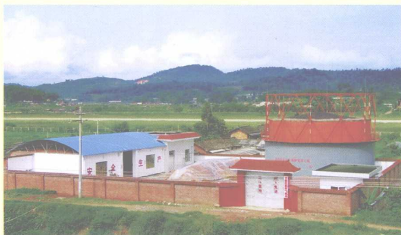
云南建成的秸秆气化集中供气站
