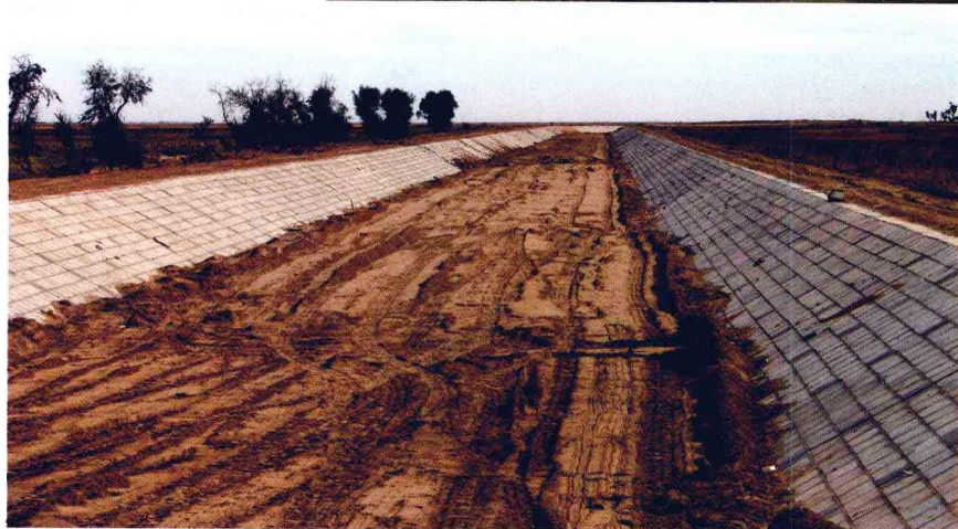
内蒙古南岸灌区水权 转换前渠道状况(二)
