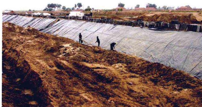
内蒙古水权转换试点节水 改造工程施工现场(一)
