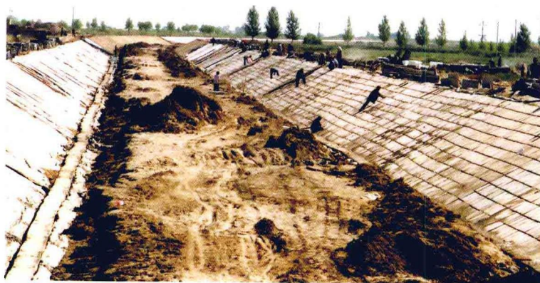
内蒙古水权转换试点节水 改造工程施工现场(二)
