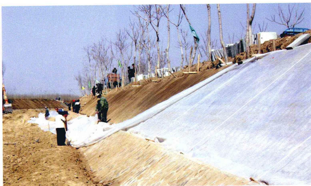
宁夏秦渠水权转换节水改造工程施工现场
