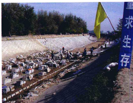
宁夏惠农渠水权转换节水改造工程施工现场
