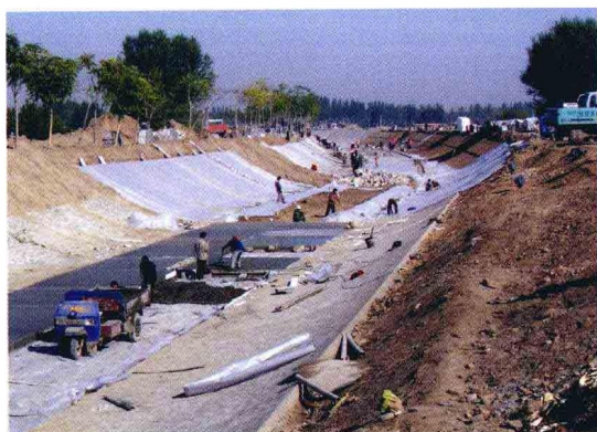
宁夏唐徕渠水权转换节水改造工程施工现场
