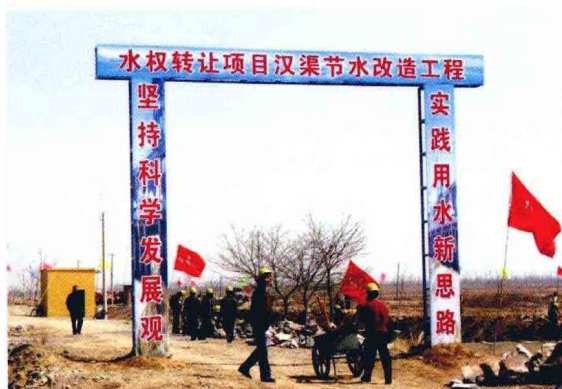
宁夏汉渠水权转换节水改造工程施工现场
