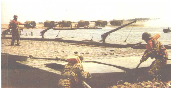
舟桥部队在搭浮桥
