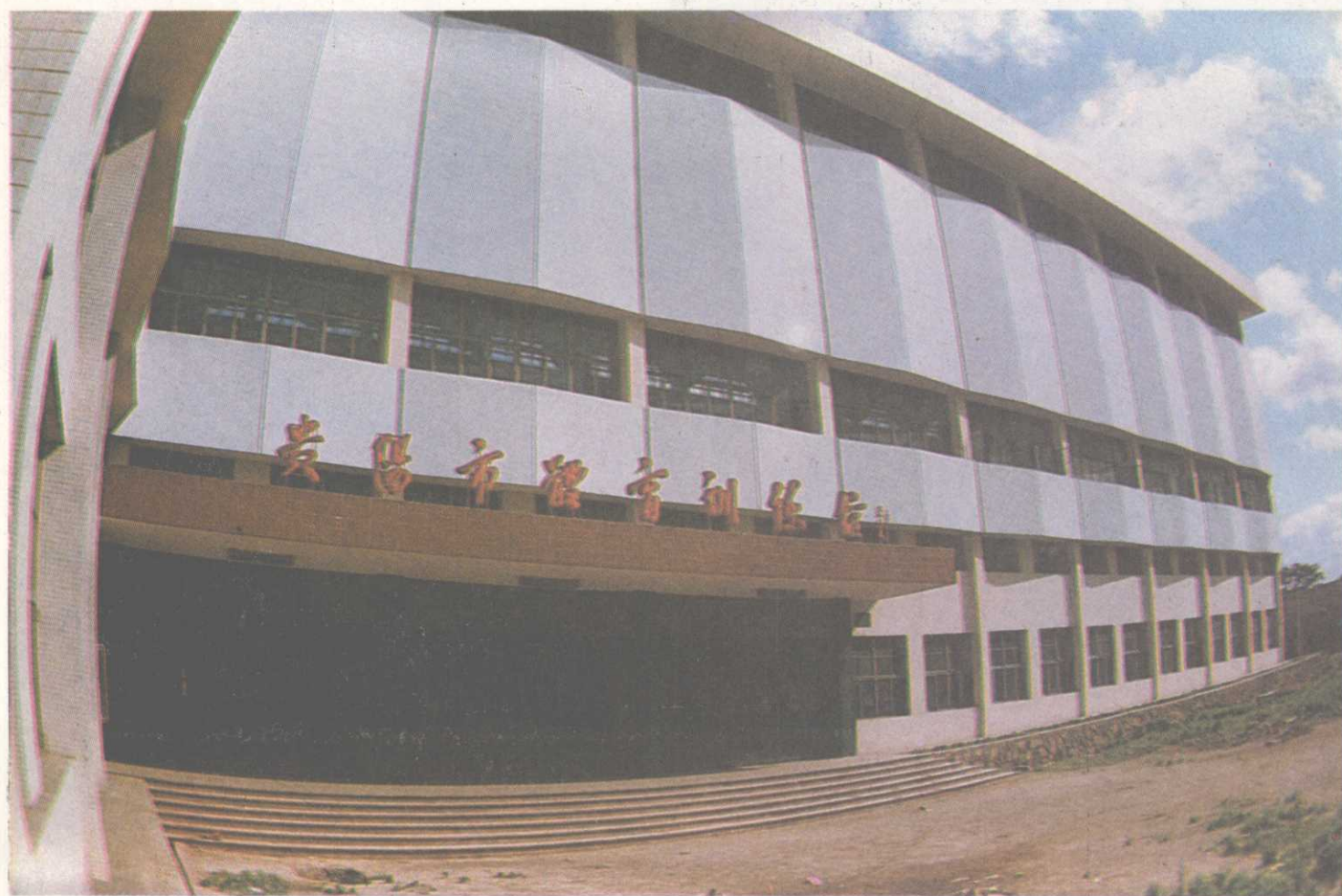
新建的多功能体育训练基地——贵阳市体育训练馆
