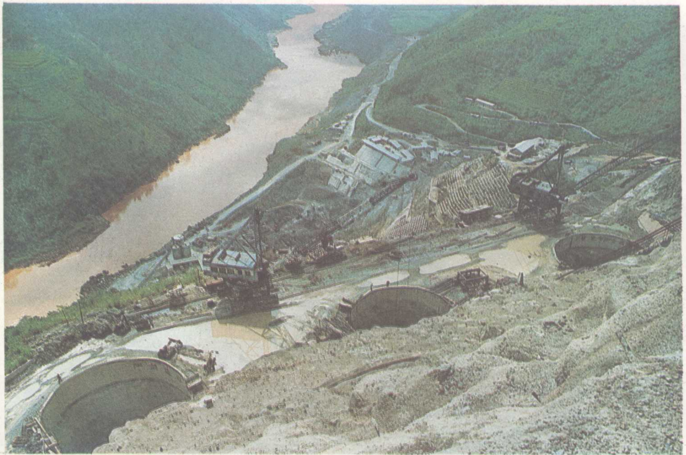
正在加紧建设中的贵州天生桥水电站
