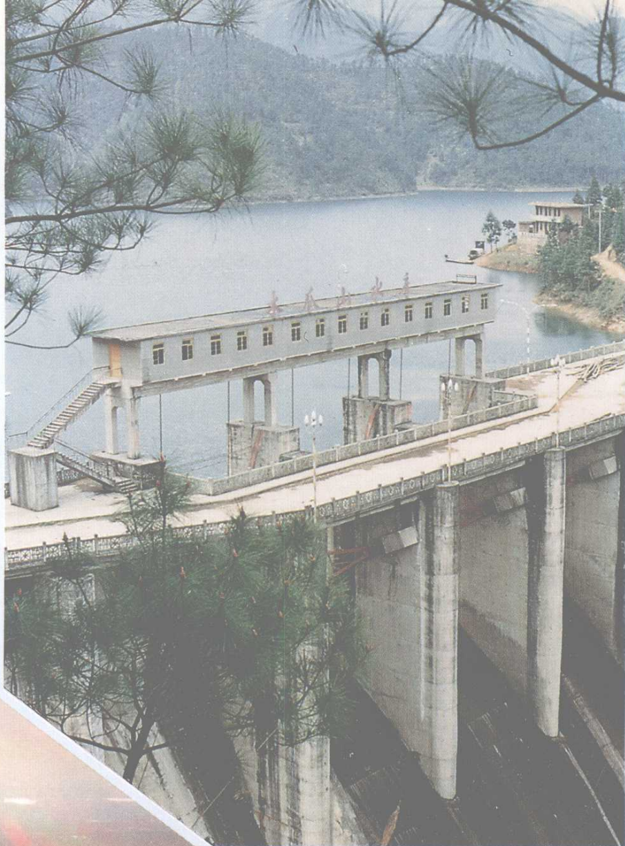
木瓜山水库大坝
