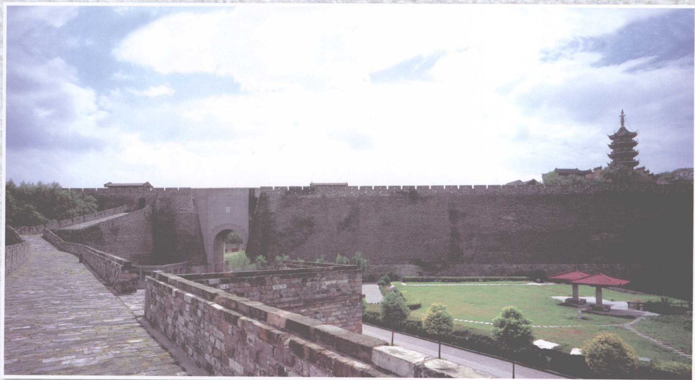
维修后的南京“台城”段内外
