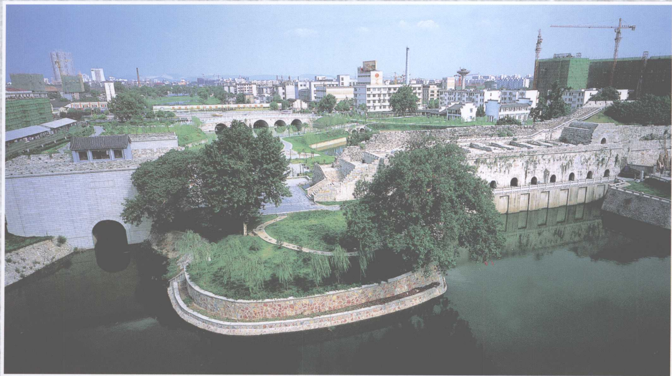
修缮后的南京城墙东水关全景
