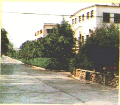
▲ 烧碱车间外景
