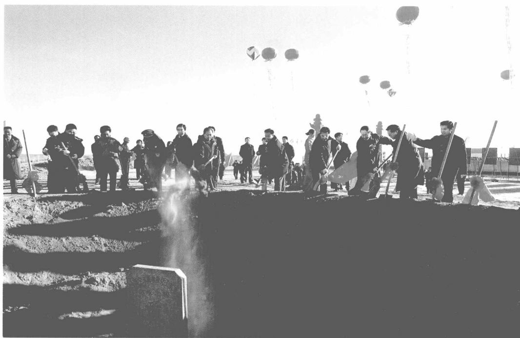
2003 年 12 月 26 日,自治区主要领导参加宁东供水工程开工奠基仪式
