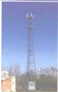
② 乡村数字移动通信信号塔
