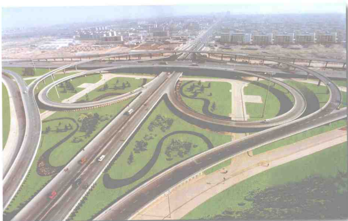
西安北二环未央路立交桥由东西 1120 米、南北 780 米的两条主线和 10 条左右转匝道组成，为西北地区最大的四层互通式城市立交桥。（陈 力 / 摄）
