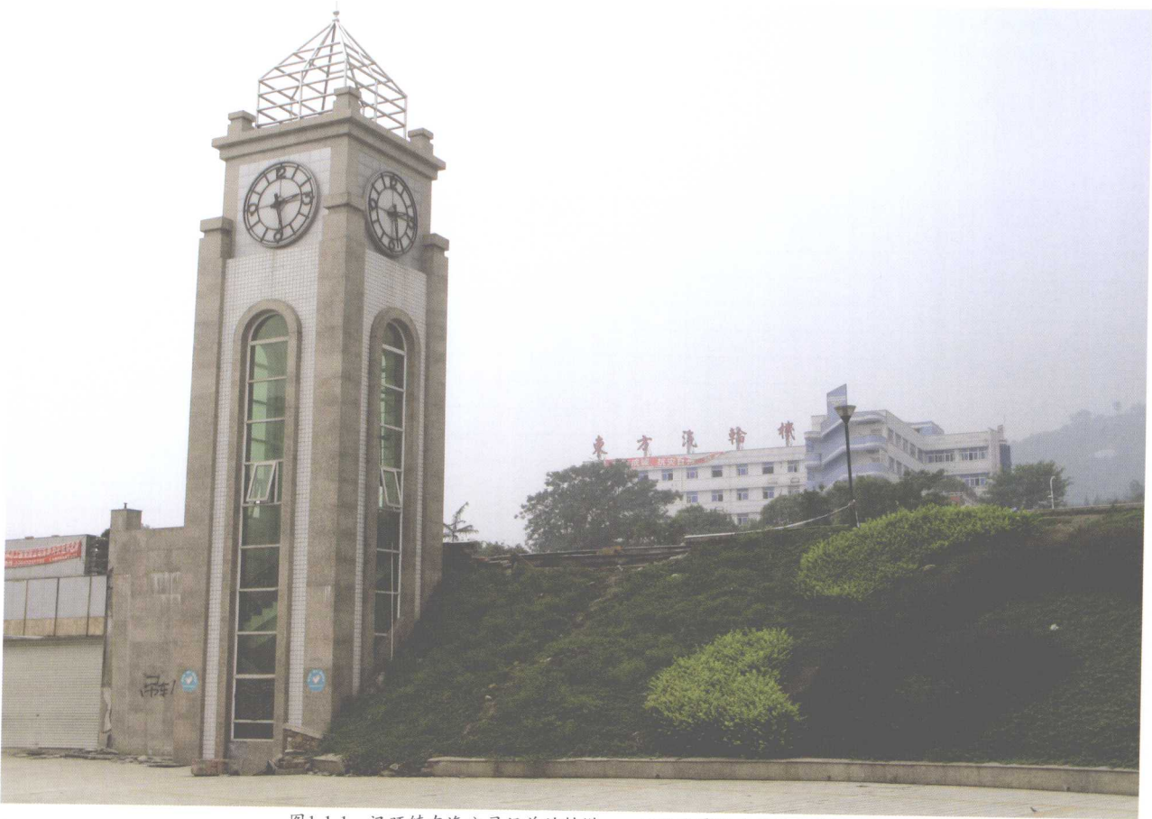
图1-1-1 汉旺镇东汽公司门前的钟塔——汶川地震发生时间的见证
