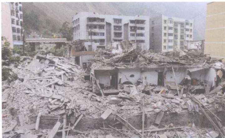
图1-2-7 城镇震害(一)(网络照片)
