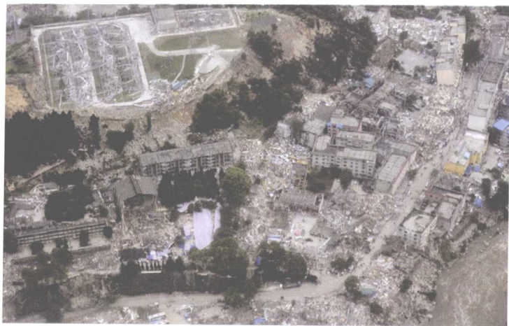
图1-2-6 震害航拍照片（四）（网络照片）
