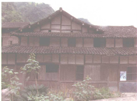
图1-21 浙江温州楠溪江林坑村民居
