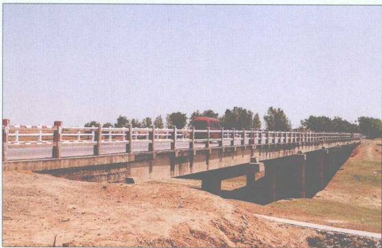
老漳河公路桥
