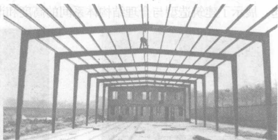
图 1-4 典型的门式刚架结构
