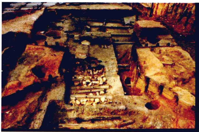
南 越 国 木 构 水 闸
