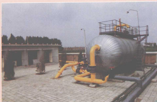
一汽输汽站输气装置
