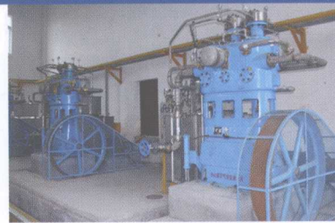
200m³/h 高压氧气压缩机
