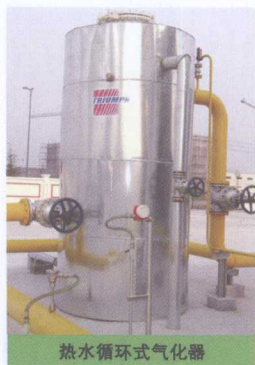
热水循环式气化器
