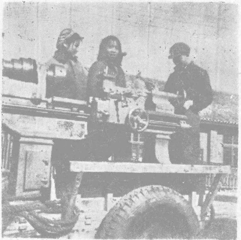
县通用机械厂试制成功的六尺皮带车床
