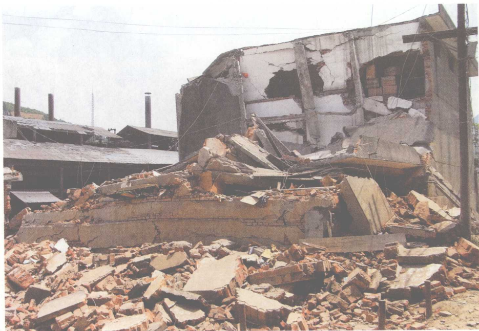
文县碧口镇倒塌的房屋。
