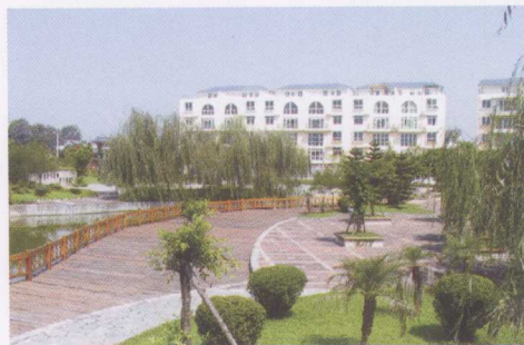
邓双镇新建居民住宅 小区——静水楼台
