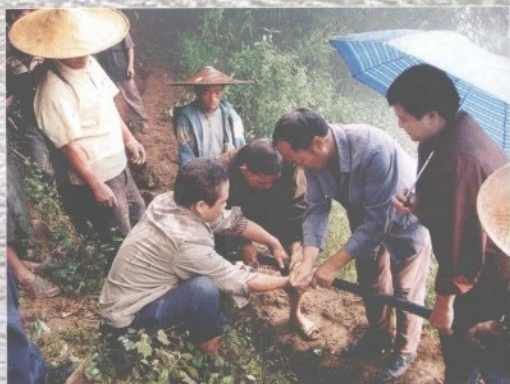
安装农村安全饮用水管
