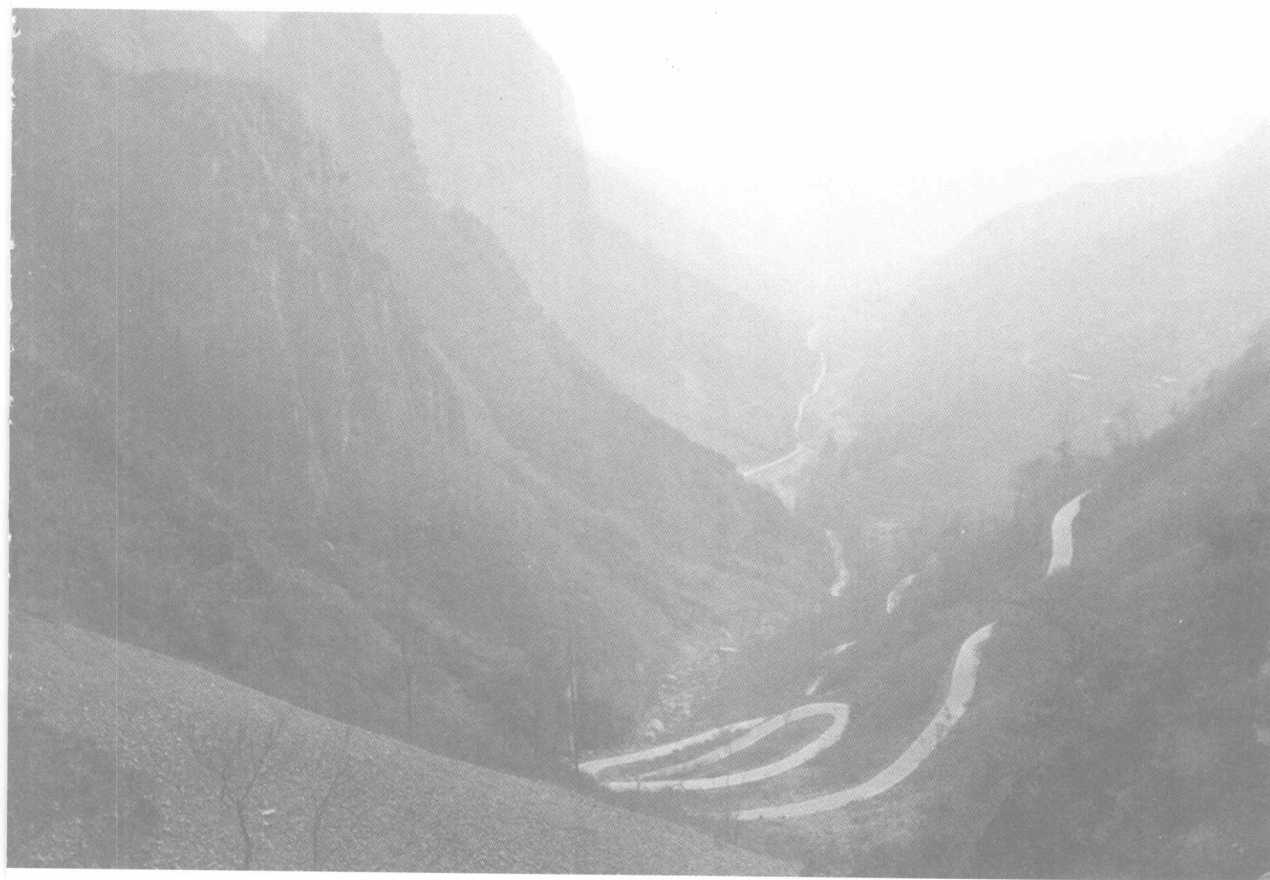
晋豫交界处的壶关县黄崖底盘山公路。突然崛起的太行山阻断了晋豫交通,直至 21 世纪初,山民的最大力量仅仅是在其绝壁上修出不足 2 米的蛇行小道,山地的意志阻断了山西人下山的梦想。(作者 / 摄)
