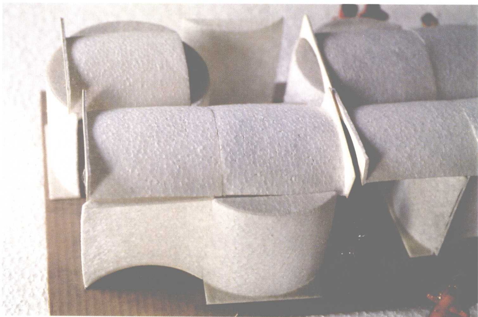
曲面板材建造的房屋。同样的板材可以用作墙体材料和屋面板。(以色列, 1953年)
