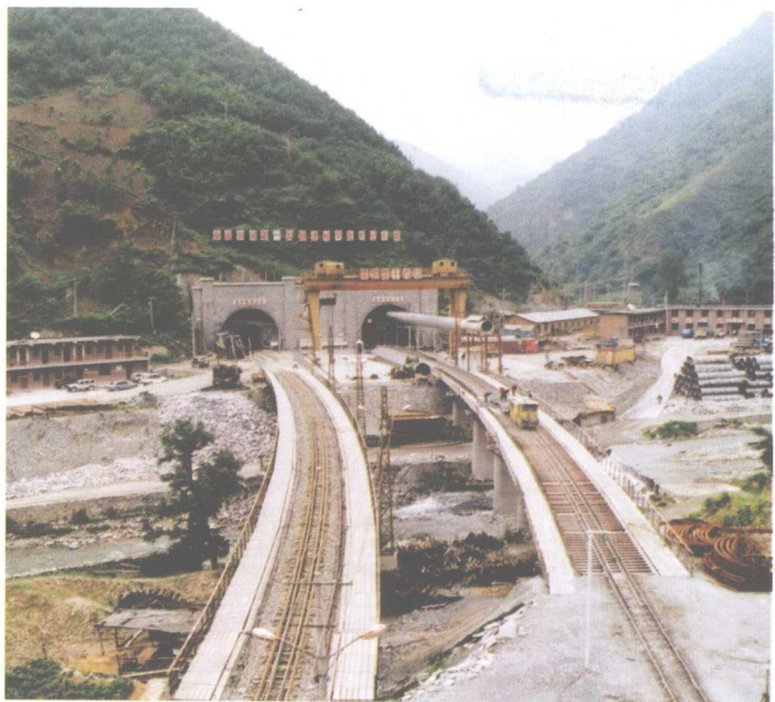
西安—安康铁路秦岭隧道 (陈琳摄)
