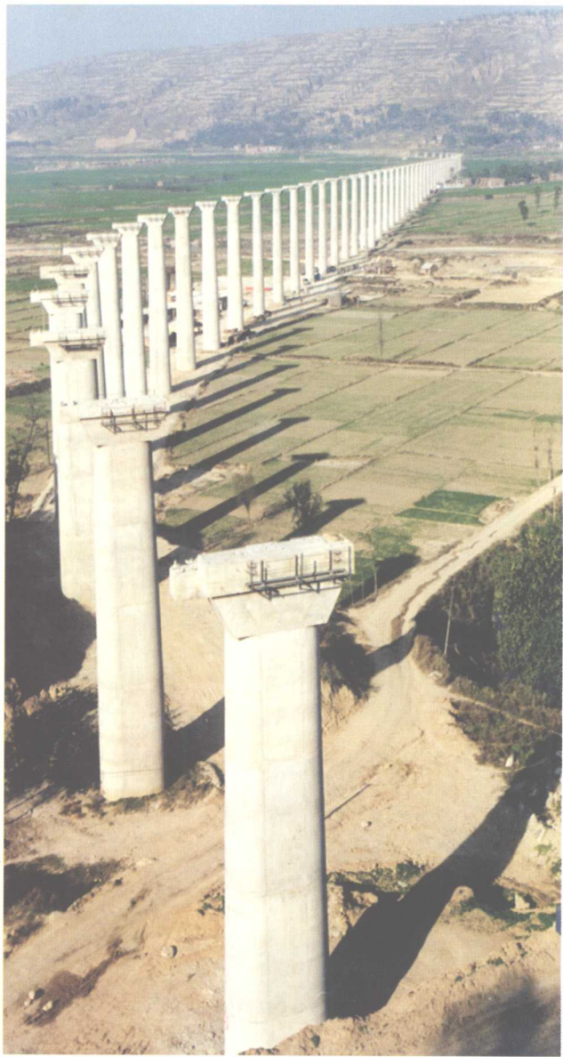
建设中的神木—榆林铁路大桥 (陈琳摄)
