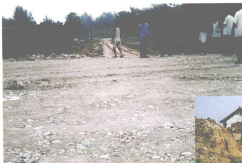
① 沁河左岸堤防上填筑的砂砾石
