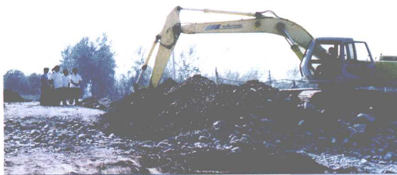
② 沁河右岸被损毁的堤防及填筑的砂砾石
