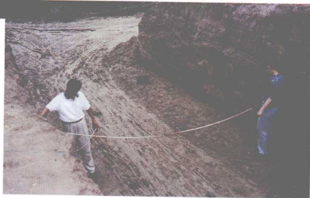
④ 水政人员现场勘察取证
