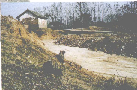
② 沁河右岸被损毁的堤防及填筑的砂砾石
