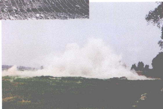
➡ 爆破拆除现场
