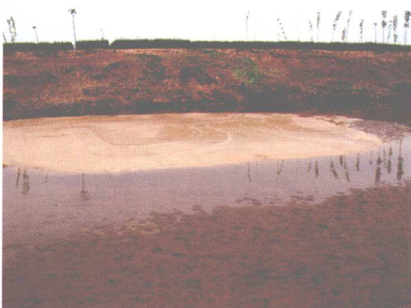
② 河槽冒浆
