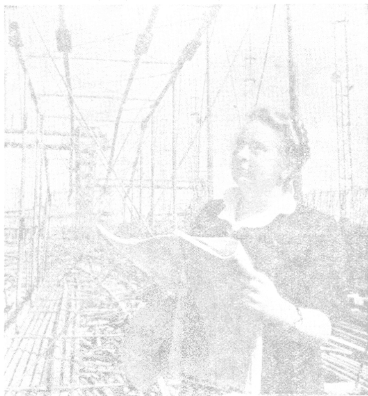
女工程師在檢查鋼鐵水閘工程
