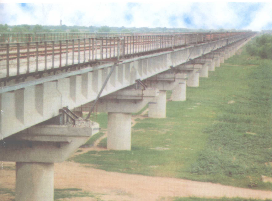
京九铁路——滹沱河大桥
