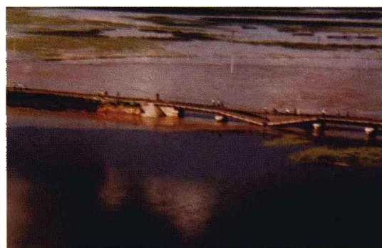
1996年7月，洪水将通辽市扎鲁特旗铁路桥冲毁
