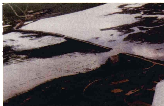
1996年7月，通辽市扎鲁特旗水库被暴雨引发的洪水冲毁
