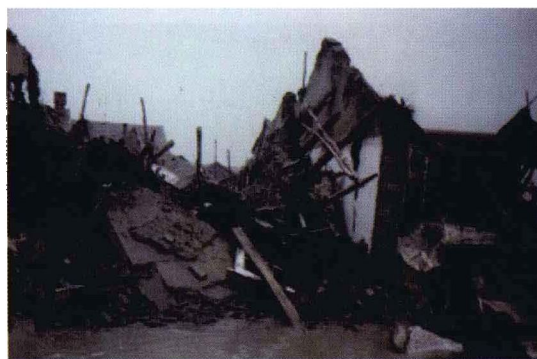
1996年7月28日，锡林郭勒盟那仁宝力格苏木遭受洪水侵袭，部分民房倒塌
