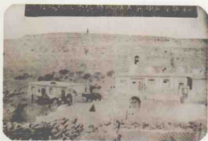
1920年保晋公司第五矿厂斜坑口运煤情形（选自《山西矿务志略》）
