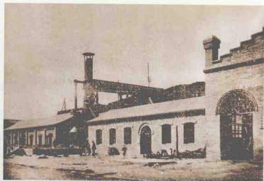
1920年保晋公司阳泉铁厂锅炉房（选自《山西矿业志略》）
