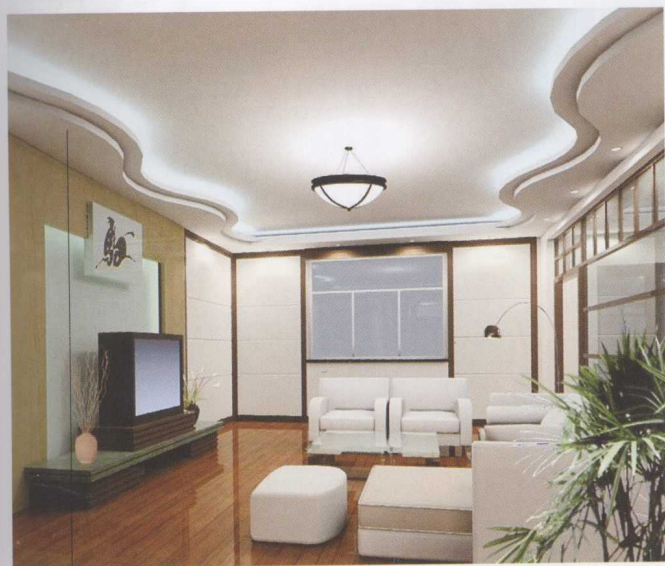
石膏板造型吊顶
