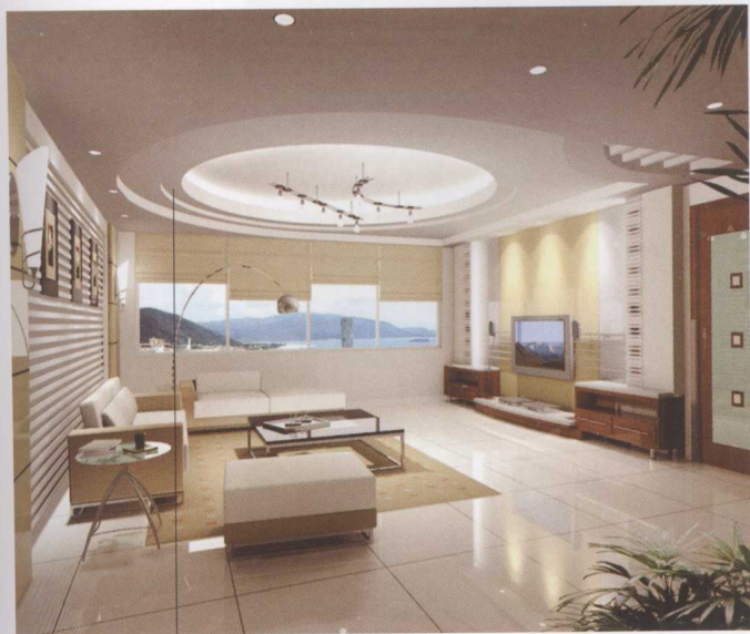
石膏板造型吊顶
