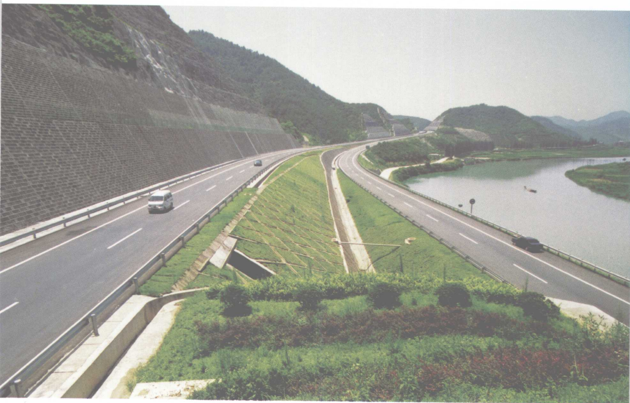
■ 武义段高速公路穿越于青山绿水间
