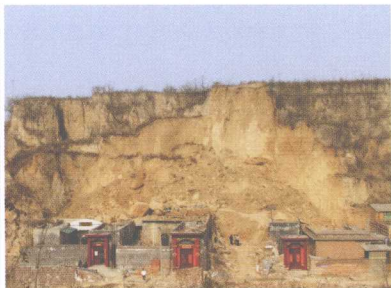
黄土崩塌(巩义市站街镇南瑶湾村)
