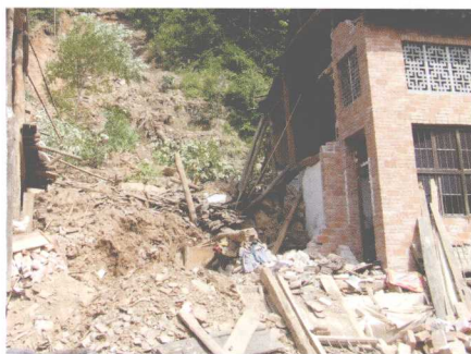
滑坡毁坏的房屋(河南省卢氏县)
