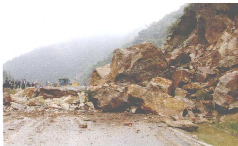
山体崩塌(312国道西峡段)
