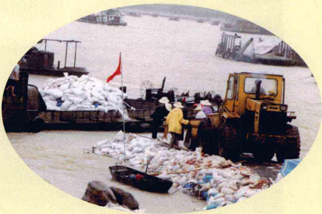
1998年7月1日，市交通集团公司船只满载沙包为荷村水闸堵缺口作爆破沉船准备。
