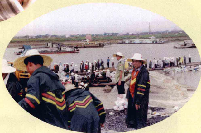
1998年7月1日，交通局地方公路管理站道班人员在荷村抢修被洪水冲毁的河堤，保障防洪通道畅通。
