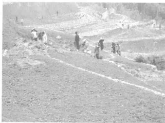
照片4 项目区覆土过程
