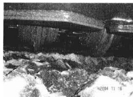
图12 混合岩工作面,裂隙发育,较易破岩
