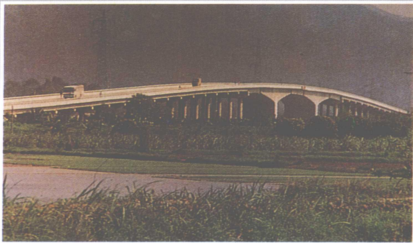
◀ 1990年6月25日建成的虎坑大桥，长734米，宽13米。
